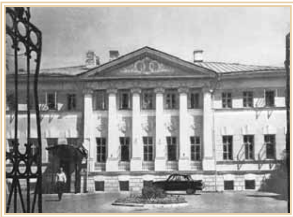
Фасад главного дома усадьбы Долговых
